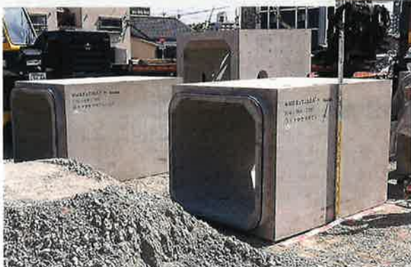
北九州市上下水道局 北鷹見町地内他雨水管渠築造工事 MMSボックス 1100×1100
