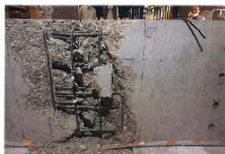
側壁外側破壊部
