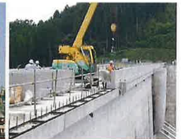
ダム 残存型枠
